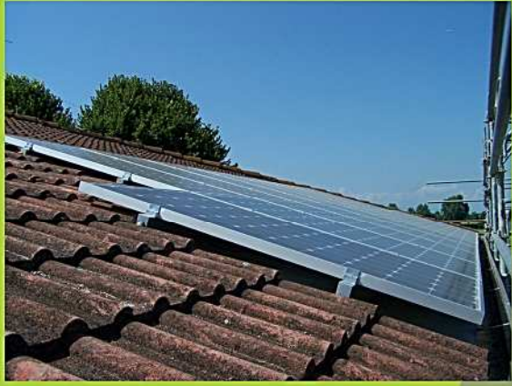
MANTOVA (MN) applicazione classica per fissare i moduli su quattro punti
