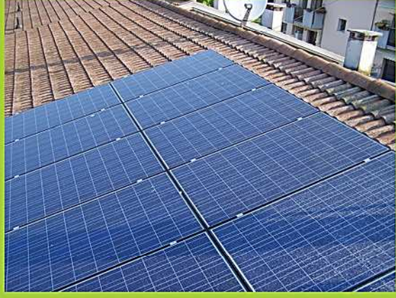
MANTOVA (MN) applicazione classica per fissare i moduli su quattro punti
