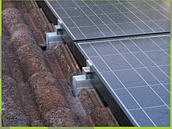
MANTOVA (MN) le strutture lineari funzionano d elementi passacavi e supporto per i cavi del modulo
