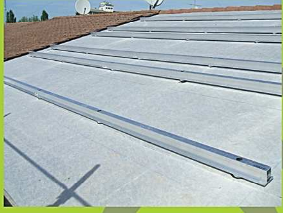
MANTOVA (MN) le strutture lineari funzionano d elementi passacavi e supporto per i cavi del modulo
