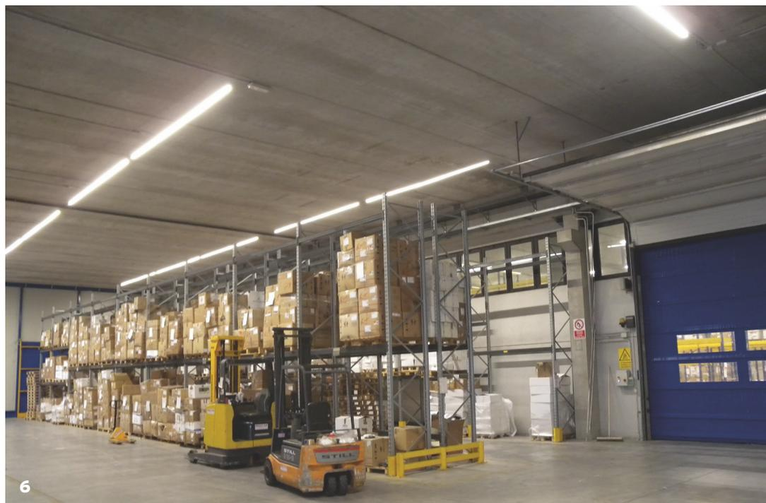
le barre di alimentazione. Circa il 70% delle barre esistenti, situate in posizione facilmente accessibile, sono state mantenute, mentre le restanti sono state implementate con nuovi alimentatori e riconvertite in bassa tensione.
